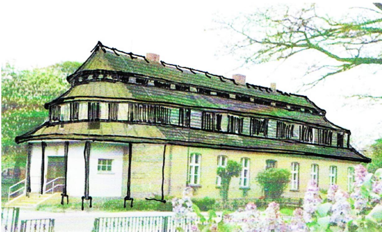
**BILD 2:** Entwurf für das Reetdach mit doppelter Gaube für optimale Lichtverhältnisse im Haus
